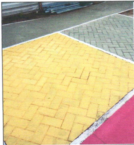
FOTO - 12 - PINTURA ACRILICA EM PISO CIMENTADO DUAS DEMAOIS
