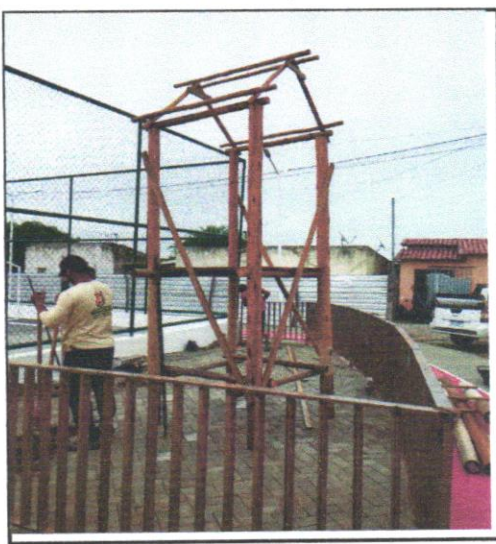
FOTO - 30 - Grade de ferro com barra quadrada de 1/2" na vertical, barras de quadrada de 1/2" na horizontal e quadro com barra de ferro de 1/2", inclusive chumbadores com parafusos
