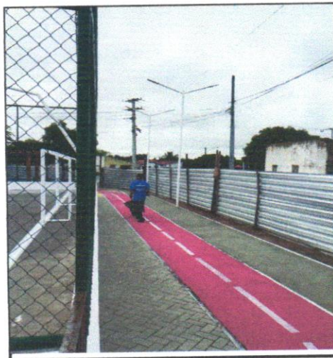
FOTO - 04 - POSTE DE AÇO CONICO CONTÍNUO CURVO SIMPLES, ENGASTADO, H=9M, INCLUSIVE LUMINÁRIA, SEM LÂMPADA - FORNECIMENTO E INSTALAÇÃO. AF_11/2019
