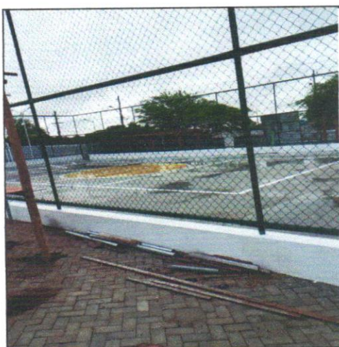
FOTO - 08 - PINTURA ACRILICA EM PISO CIMENTADO DUAS DEMAOS
