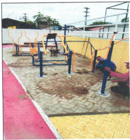
FOTO - 24 - INSTALAÇÃO DE PLACA ORIENTATIVA SOBRE EXERCÍCIOS, 2,00M X 1,00M, EM TUBO DE AÇO CARBONO - PARA ACADEMIA AO AR LIVRE
