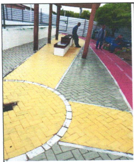
FOTO - 27 - PINTURA ACRILICA EM PISO CIMENTADO DUAS DEMAOIS
