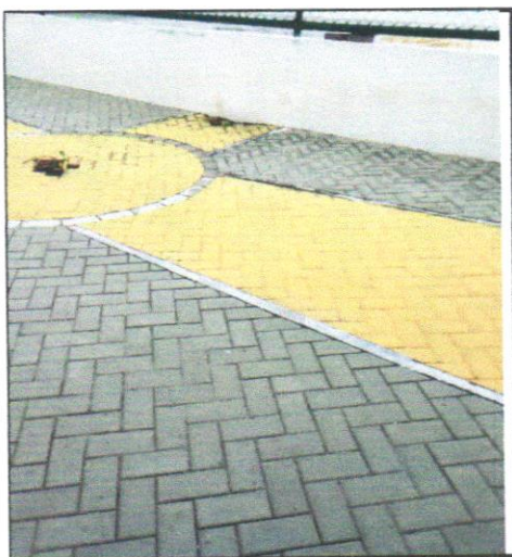
FOTO - 13 - PINTURA ACRILICA EM PISO CIMENTADO DUAS DEMAOS
