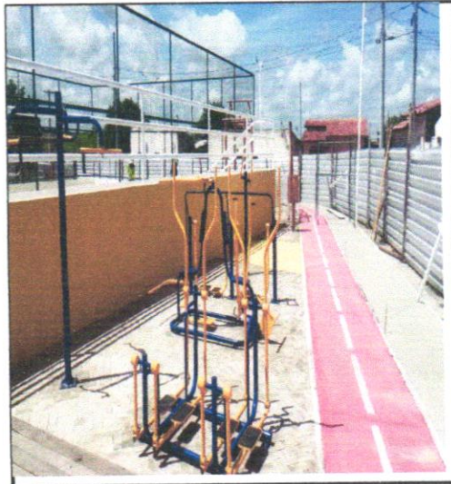
FOTO - 40 - INSTALAÇÃO DE SIMULADOR DE CAMINHADA TRIPLO, EM TUBO DE AÇO CARBONO - EQUIPAMENTO DE GINÁSTICA PARA ACADEMIA AO AR LIVRE
