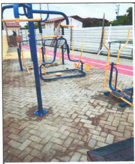
FOTO - 25 - INSTALAÇÃO DE ALONGADOR COM TRÊS ALTURAS, EM TUBO DE AÇO CARBONO - EQUIPAMENTO DE GINÁSTICA PARA ACADEMIA AO AR LIVRE / ACADEMIA DA TERCEIRA IDADE -
