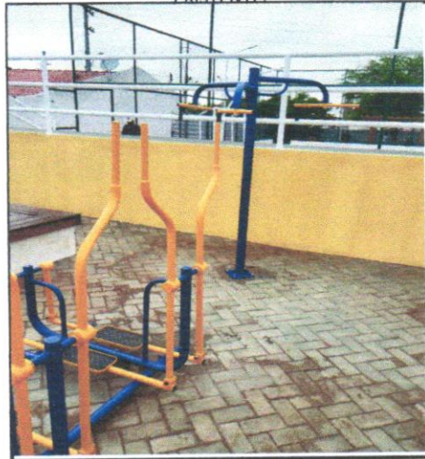
FOTO - 10 - INSTALAÇÃO DE MULTIEXERCITADOR COM SEIS FUNÇÕES, EM TUBO DE AÇO CARBONO - EQUIPAMENTO DE GINÁSTICA PARA ACADEMIA AO AR LIVRE / ACADEMIA DA TERCEIRA IDADE - ATI, INSTALADO SOBRE PISO DE CONCRETO EXISTENTE.
